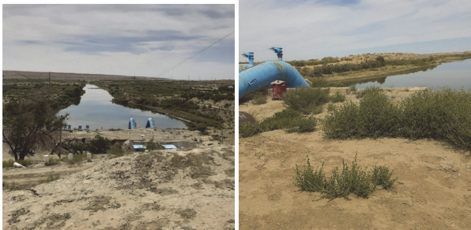
Рис. 5. Озеро Каратерень (перекачивающая станция с двумя насосами мощностью 5 м 3 /с) Fig. 5. Karateren lake (pumping station with two pumps capacity 5 m 3 /s)
